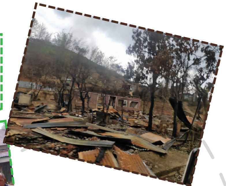
UMA ESCOLA QUEIMADA POR CAUSA DO CONFLITO
